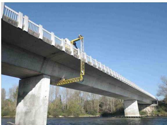
Téléinspection d'un ouvrage franchissant un cours d'eau
