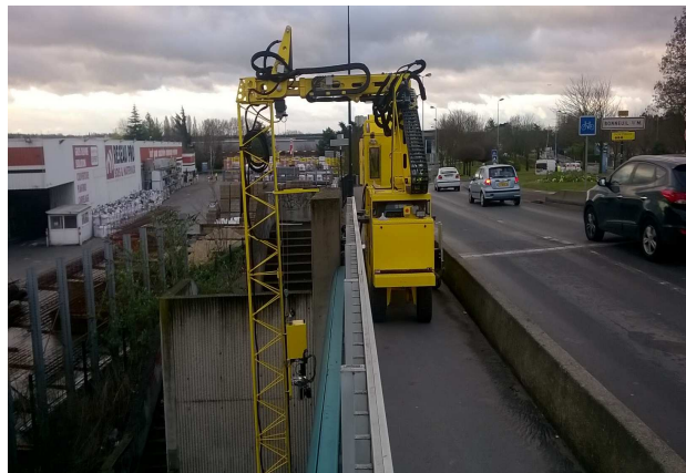
Mise en place sur un pont routier
