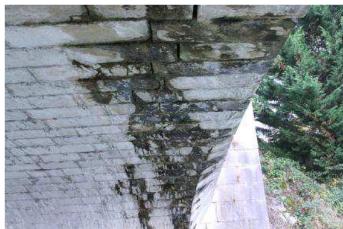
Résultats : Intrados pont en maçonnerie
