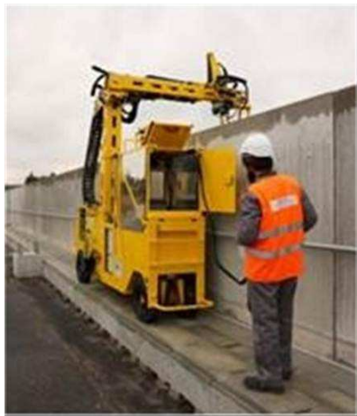
Mise en place au-delà d'un mur antibruit (Voie ferrée)
